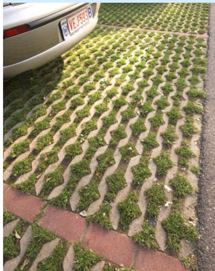
Voorbeeld van een verharding van parkeerplaatsen uitgevoerd in waterdoorlatende grasbetontegels
